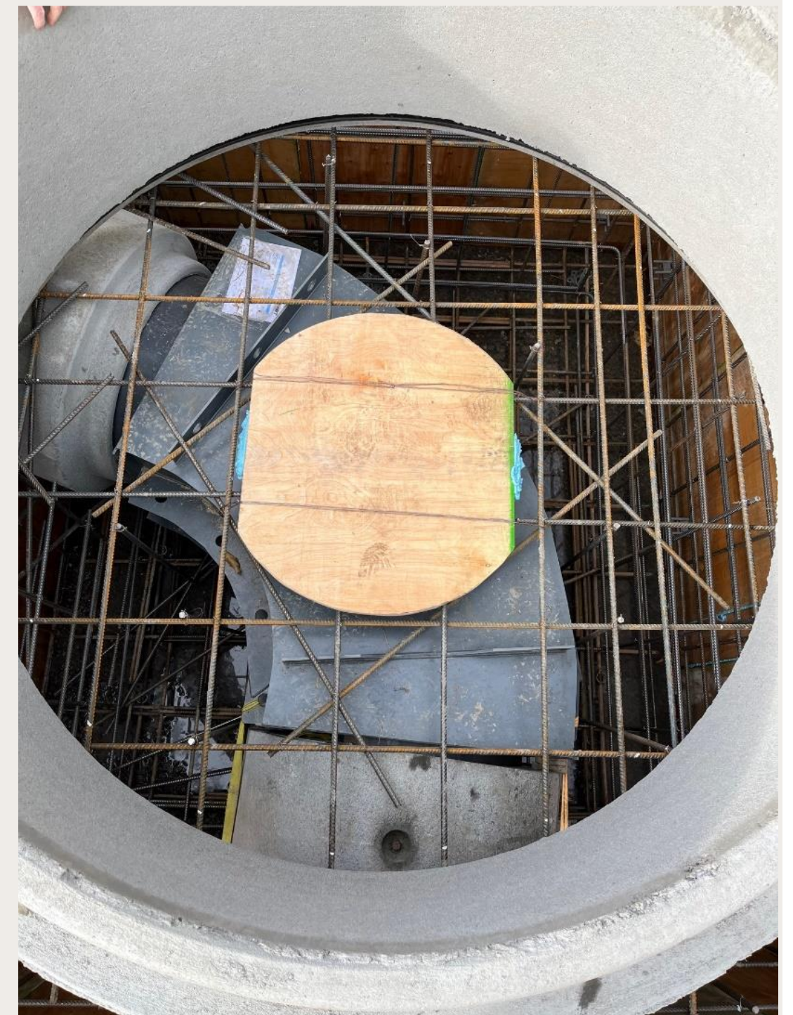
Bildet viser bygging av en plasstøpt kum i Oslo med all armeringen
